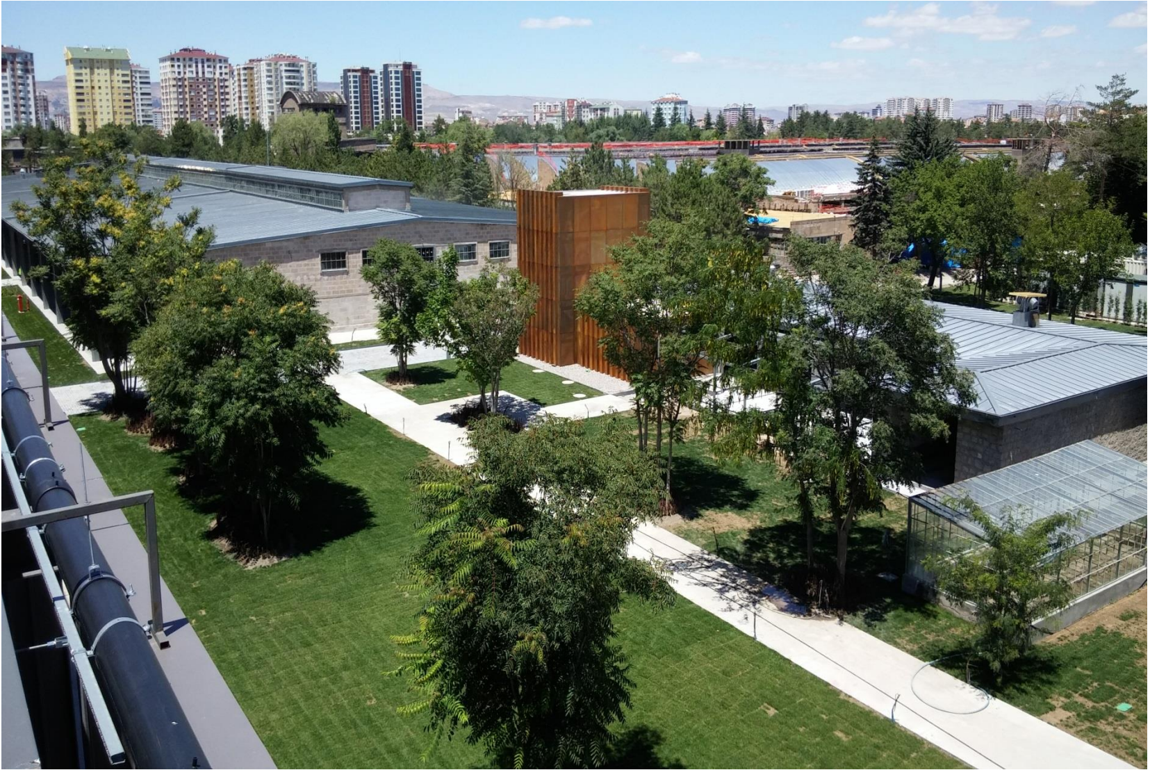
Mamul Ambarı ve İtfaiye Binası İnşaatı Şimdiki Hali
